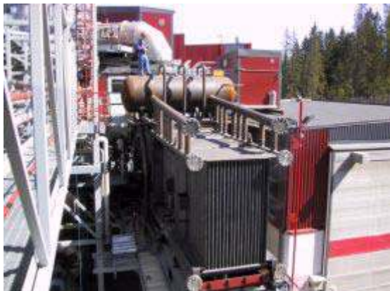
Котел для рекуперации тепла перегретого пара на установке по обработке проблемных отходов
